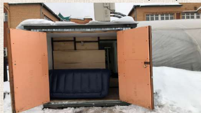
Газгольдер для хранения биогаза
